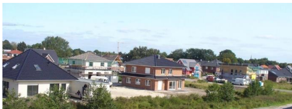
Bebauung im Plangebiet Eversten West
